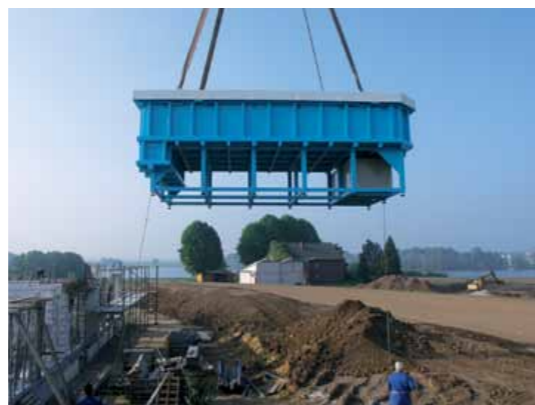
Alles Gute kommt von oben – in diesem Fall das Herzstück der Schwimmbadanlage, ein Hart-PVC-Becken von KWS.
