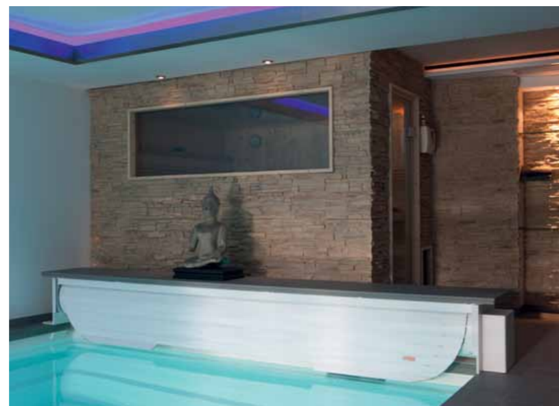
Das Becken ist mit einer Oberflur-Rollladenabdeckung ausgerüstet.
